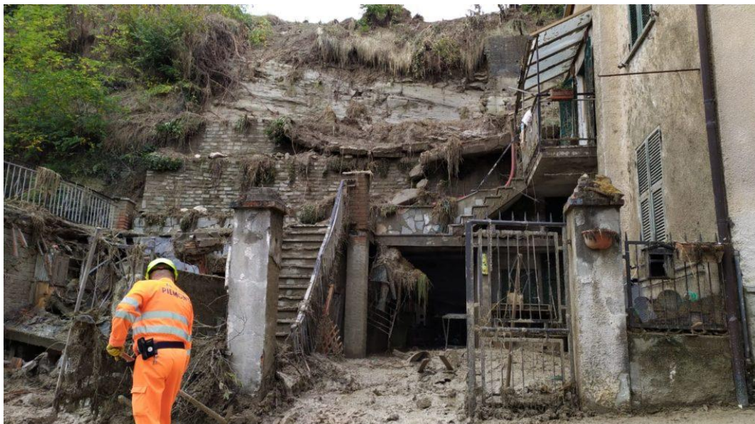
Frana nel Comune di Parodi Ligure
